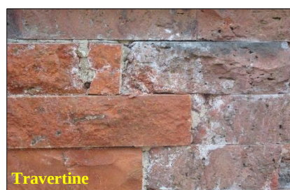
شکل ۳. آسیب زیباشناختی به سنگ نمای ساختمان به دلیل برخی فرایندهای زوال مانند آلاینده‌های اتمسفری و شوره‌زدگی Fig. 3. Aesthetic damage to building facade stone due to some deterioration processes such as atmospheric pollutants and efflorescence
