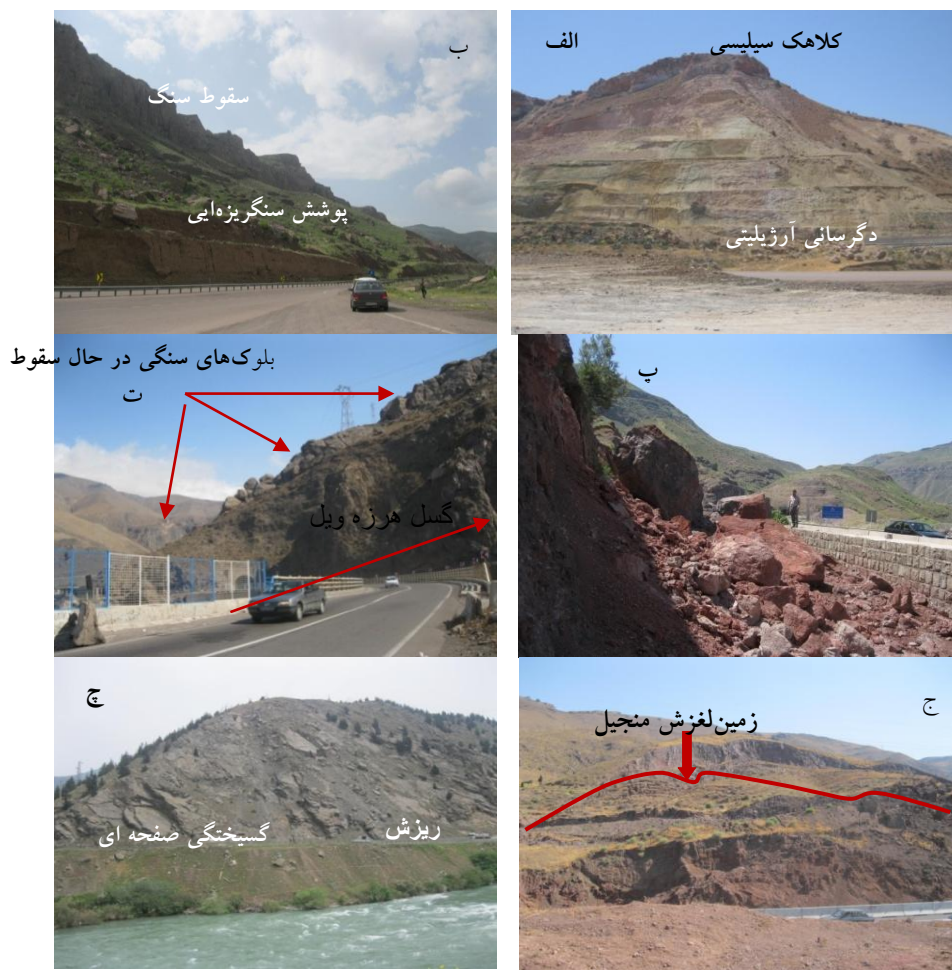
شکل ۴. نمایی از زمین لغزش‌های رخ داده در مسیر آزادراه قزوین - رشت، الف) سقوط بلوک‌های سنگی در قسمت بالای ترانشه و زمین لغزش در سری سنگ‌های آندزیت با آلتراسیون شدید (ایستگاه اول: کیلومتر ۷۰۰+۴۲). ب) سقوط و ریزش بلوک‌های سنگی در سری سنگ‌های آندزیتی و پوشش سنگریزه‌ایی در قسمت پایین ترانشه (ایستگاه ۹: کیلومتر ۶۱۰+۵۲، عکس به سمت جنوب شرق گرفته شده است. پ) ریزش بلوک‌های سنگی در سری سنگ‌های آندزیتی و نهشته‌های آذرآواری (ایستگاه ۱۰: کیلومتر ۹۰۰+۵۷). ت) سقوط و ریزش بلوک‌های سنگی در سری سنگ‌های آگلومرای خاکستری (ایستگاه ۱۵: کیلومتر ۱۴۰). ج) زمین لغزش منجیل که در تاریخ ۹۲/۴/۹۲ اتفاق افتاد و از کیلومتر ۸۰۰-۱۰۲+۵۰۰ آزادراه را مسدود کرد. عکس روبه جنوب گرفته شده است. چ) گسیختگی صفحه‌ای به موازات شیب توپوگرافی و ریزش در سری کنگلومرای هوازه سازند شمشک در ناحیه خلیل آباد رودبار (ایستگاه ۲۱: کیلومتر ۱۰۵).
