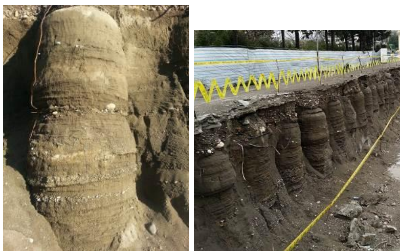
شکل ۶. برداشتن خاک اطراف ستون‌ها به‌منظور کنترل قطر
