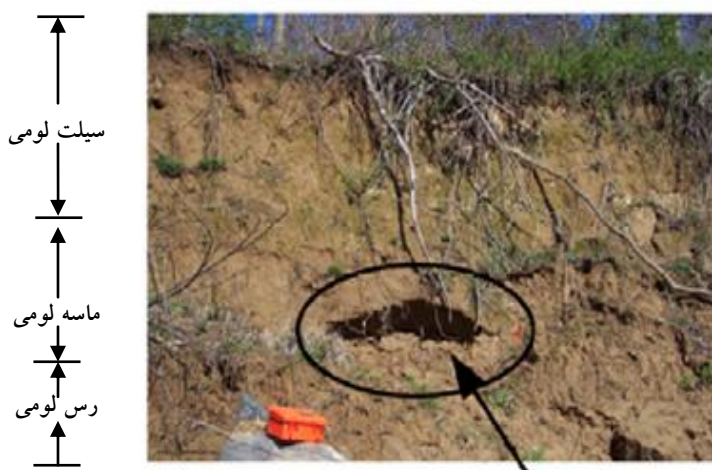
فرسایش ناشی از تراوش
