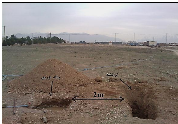
شکل ۸. نمایی از تراشه حفر شده در ۲ متری چاله تزریق (دید از غرب به شرق)
